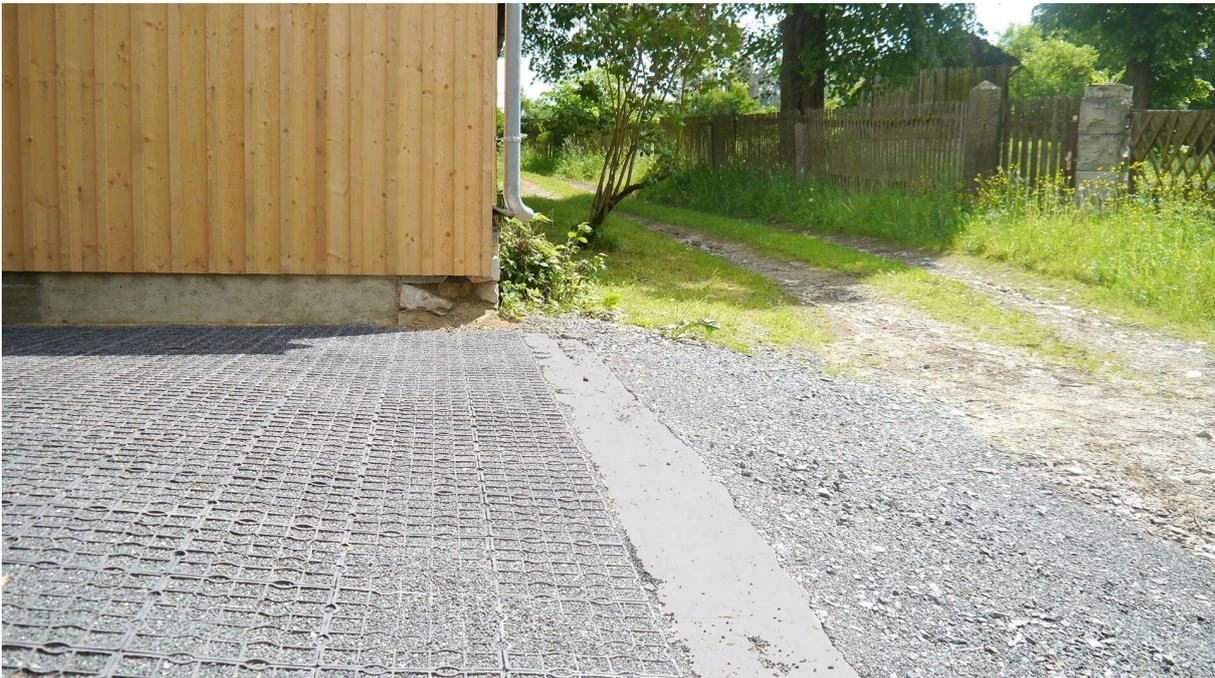
**Les grilles de sol qui permettent de rendre les voies d'accès et les chemins perméables et durables.**
